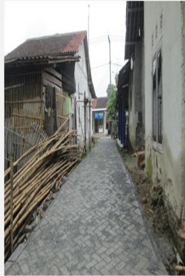
PEMBANGUNAN PAVING BLOK
