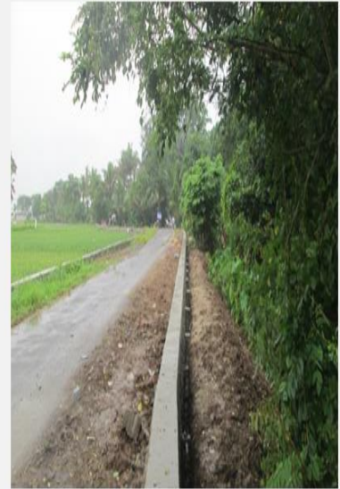
PEMBANGUNAN TURAP/TPT JALAN
